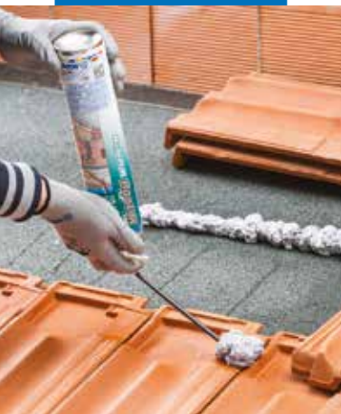
Punktweise Verklebung von Dachziegeln
