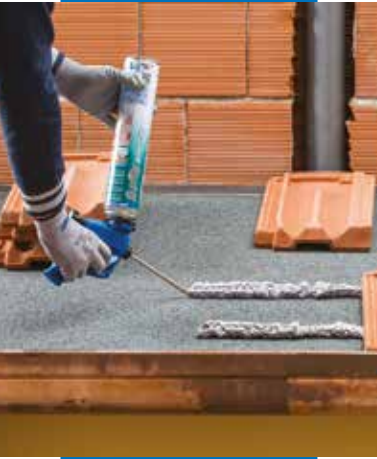
Verklebung von Dachziegeln in Streifen
